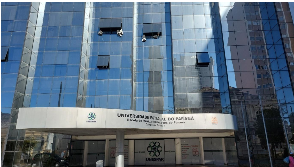
Figura 4 Prédio da Rua Barão do Rio Branco, 370
